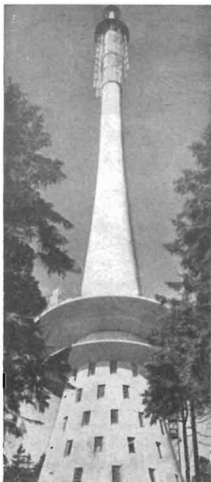
La nuova emittente TV di Ochsenskopf, nella Germania Occidentale, è montata alla base di una alta torre di cemento armato, di ben 163 m. Nei vari piani della costruzione trovano posto un trasmettitore TV di progetto Siemens, avente una potenza di uscita di 10/2 kW e lavorante in banda I; un trasmettitore FM e i ponti radio di collegamento.
